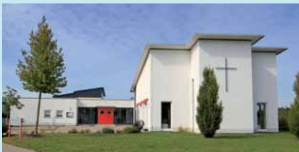
Gemeindezentrum Philipp-Melanchthon-Haus Jettingen-Scheppach
